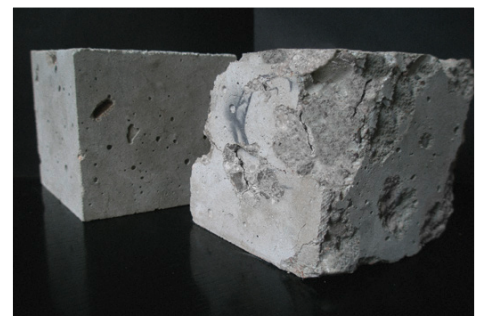
Kleinprüfkörper mit und ohne Faserzugabe nach der Brandprüfung
